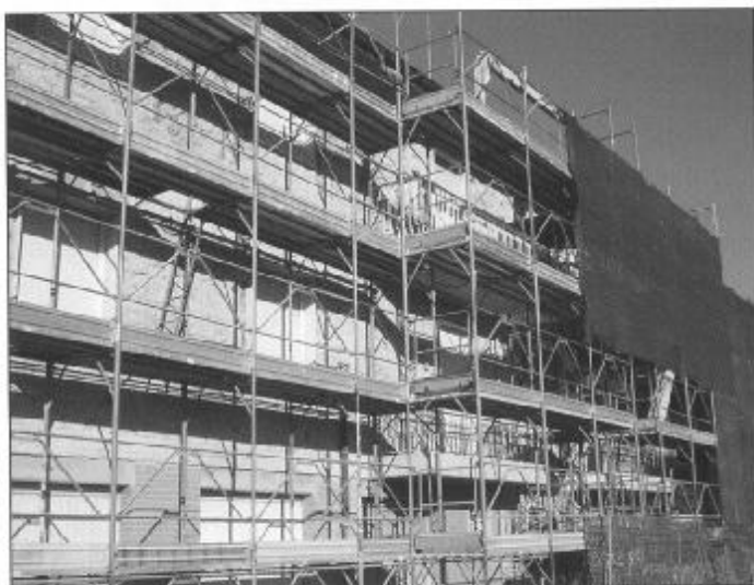
Nella foto: Oderzo via Altinate 37, 6 alloggi - rinforzo strutturale.
