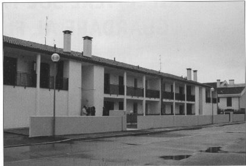
Nella foto: il fabbricato di 10 alloggi recentemente consegnato in comune di Casier
