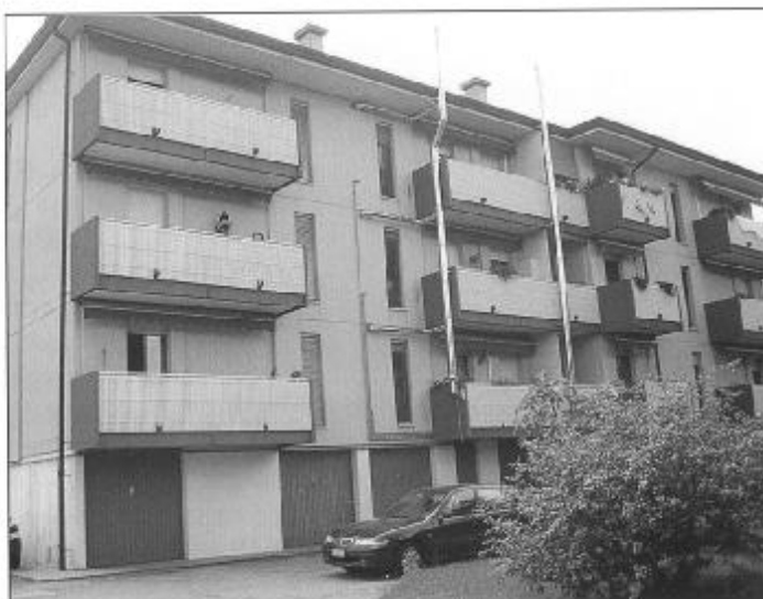
Nella foto: Treviso, Borgo Furo 59 - rifacimento pavimentazione terrazze.
